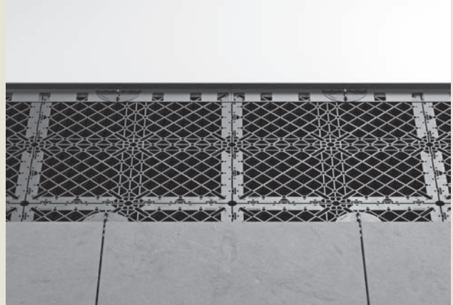
Positionnement du profilé sur les plots Positionierung des Randprofils auf den Gittern
