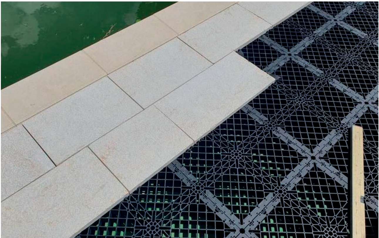
Villa privata – Bord de piscine Tribunj, Croazia GRF System – Eterno SE
