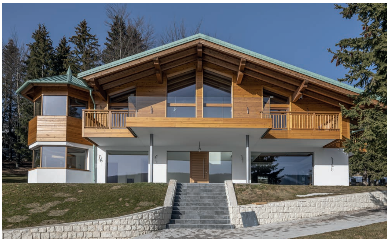
Villa privata – Rooftop, terrasses et espaces extérieurs Folgaria (TN), Italia Pedestal System – Eterno SE e Star.T
