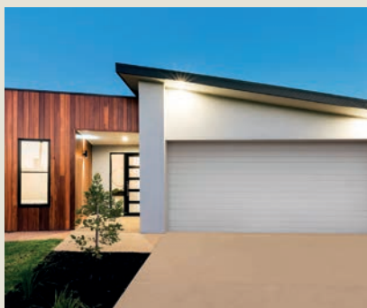
Habitations préfabriquées en béton Fertighäuser aus Beton
