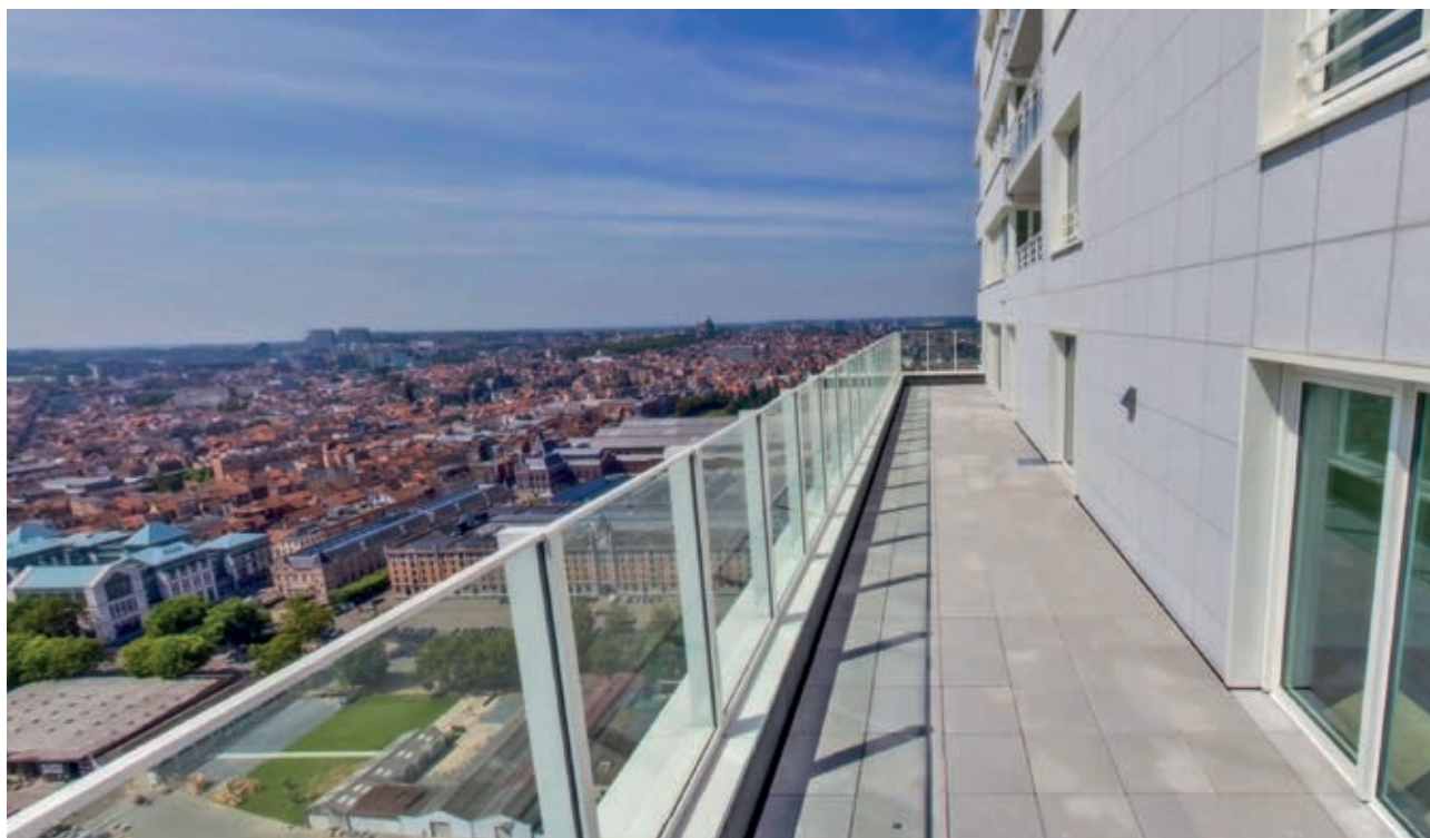
Up-site – Rooftop, terrasses et espaces extérieurs Bruxelles, Belgio
